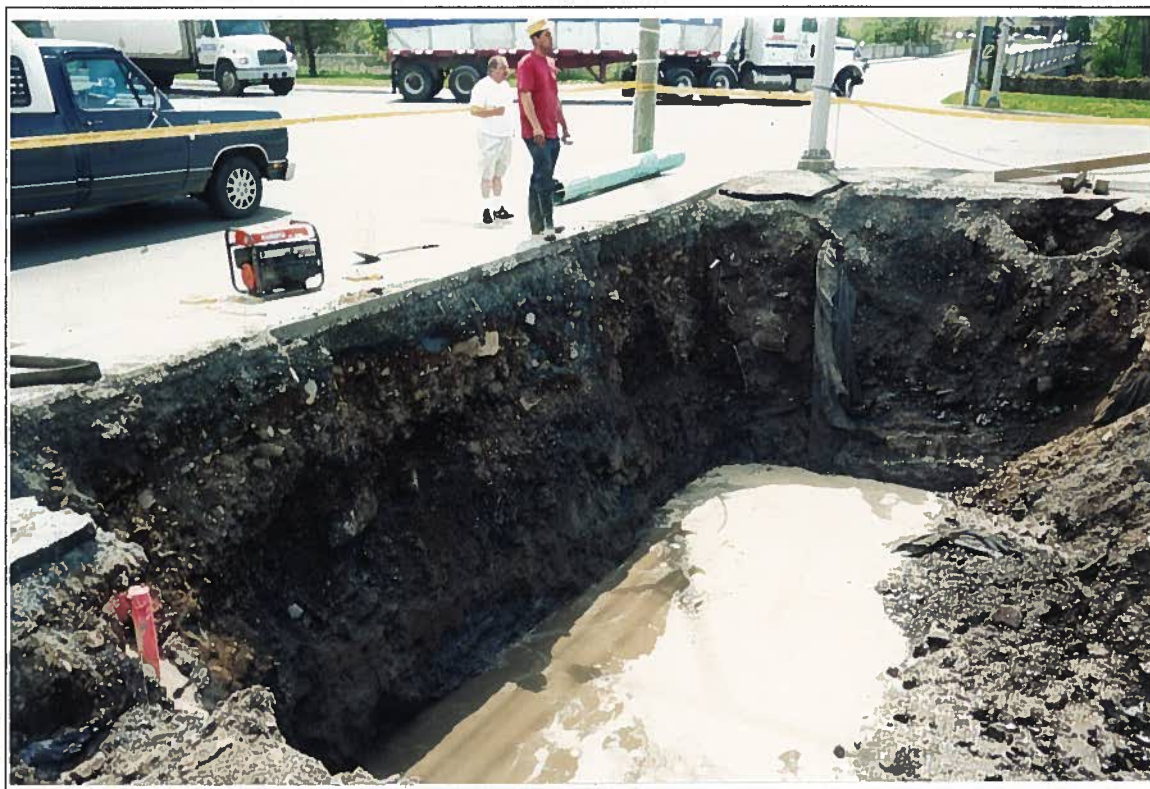
Photo 20 : Excavation de la paroi EX6 PA1 en mai 2003
