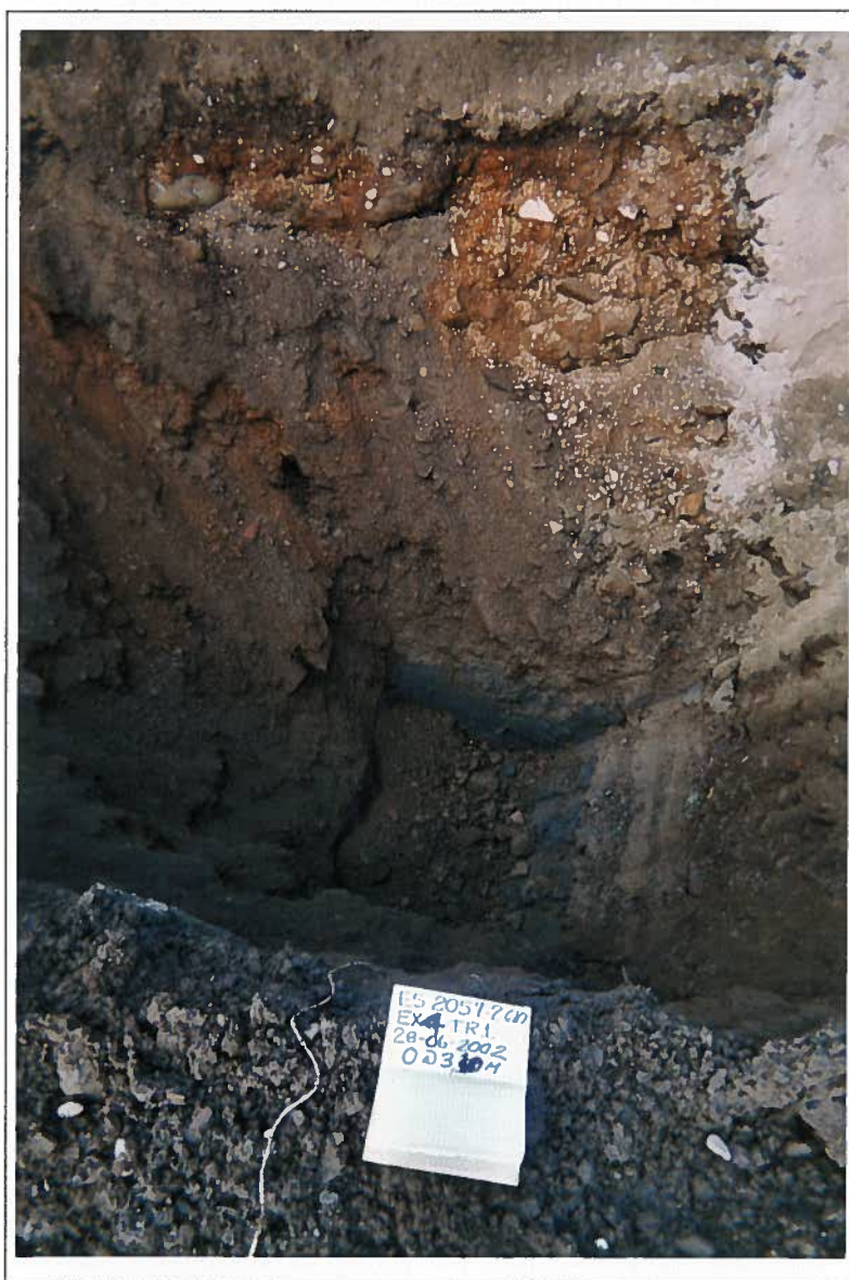
Photo 11 : Vue de la stratigraphie des sols dans la tranchée TR1
