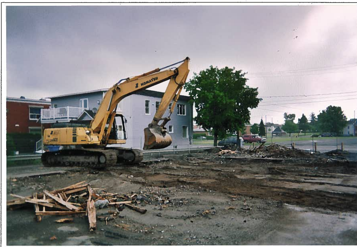
Photo 10 : Secteur du bâtiment après la démolition
