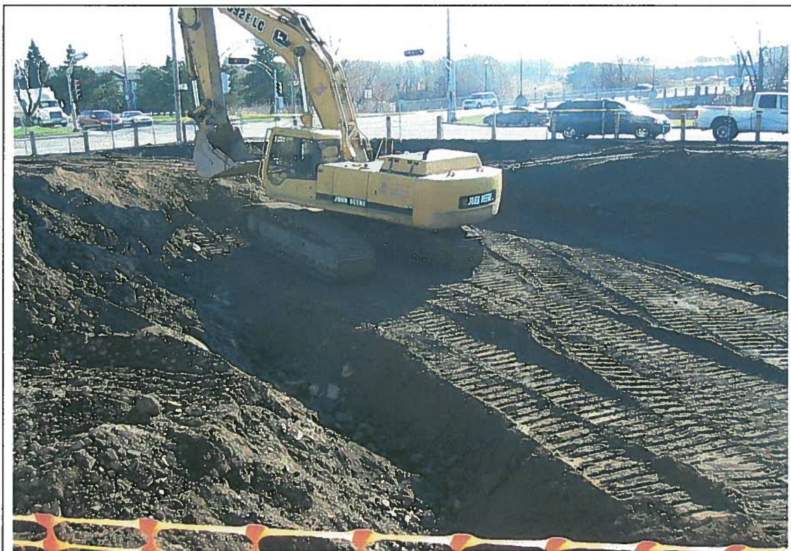
Photo 17 : Remblayage de EX4 et EX5 avec déblais préalablement excavés
