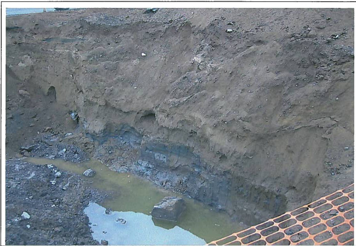
Photo 16 : Parois de EX4 et EX3
