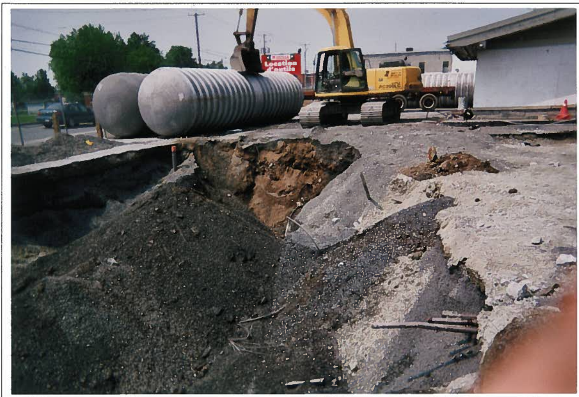
Photo 6 : Vue de l'excavation EX1 après le retrait des réservoirs
