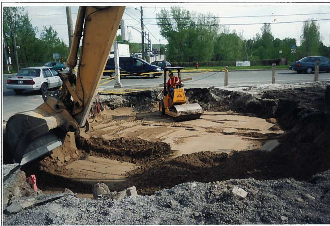
Photo 21 : Remblayage de la réexcavation EX6
