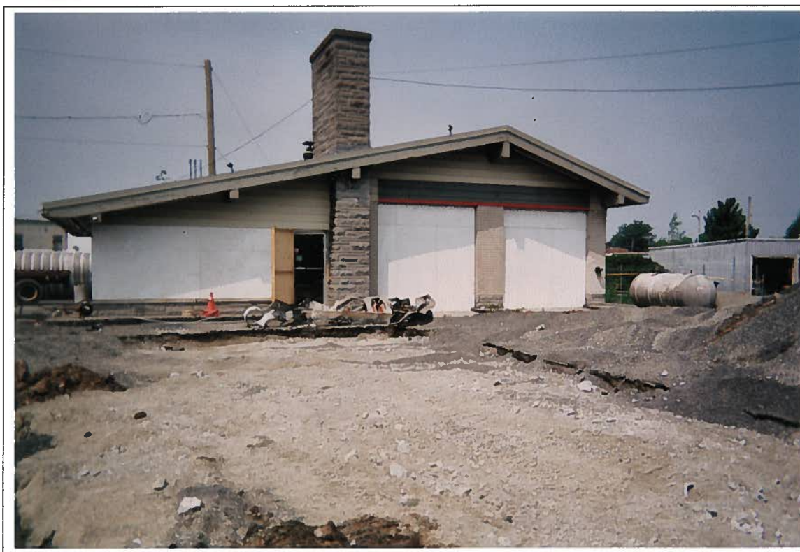
Photo 9 : Secteur des îlots de pompes après la démolition
