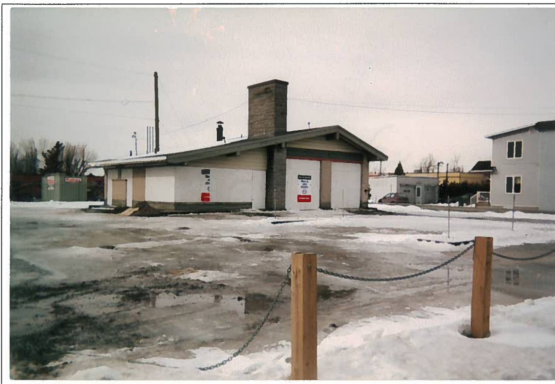
Photo 1 : Vue générale du site
