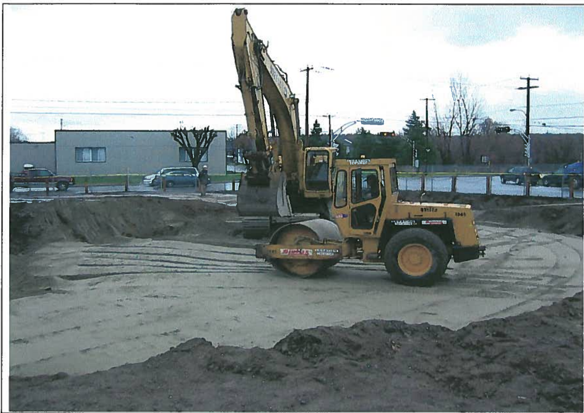
Photo 18 : Compactage à l'aide d'un rouleau compacteur
