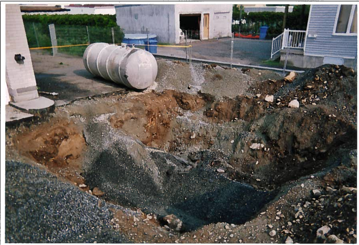
Photo 8 : Vue de l'excavation EX2
