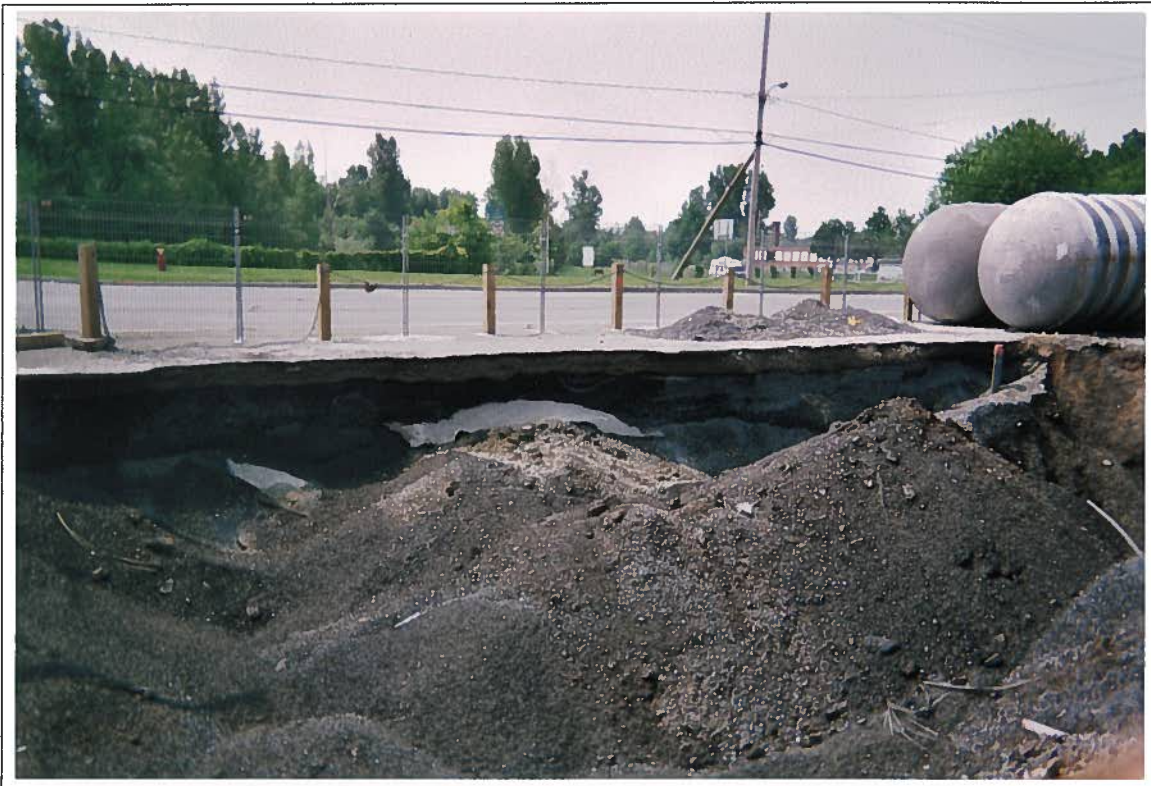
Photo 7 : Vue de l'excavation EX1
