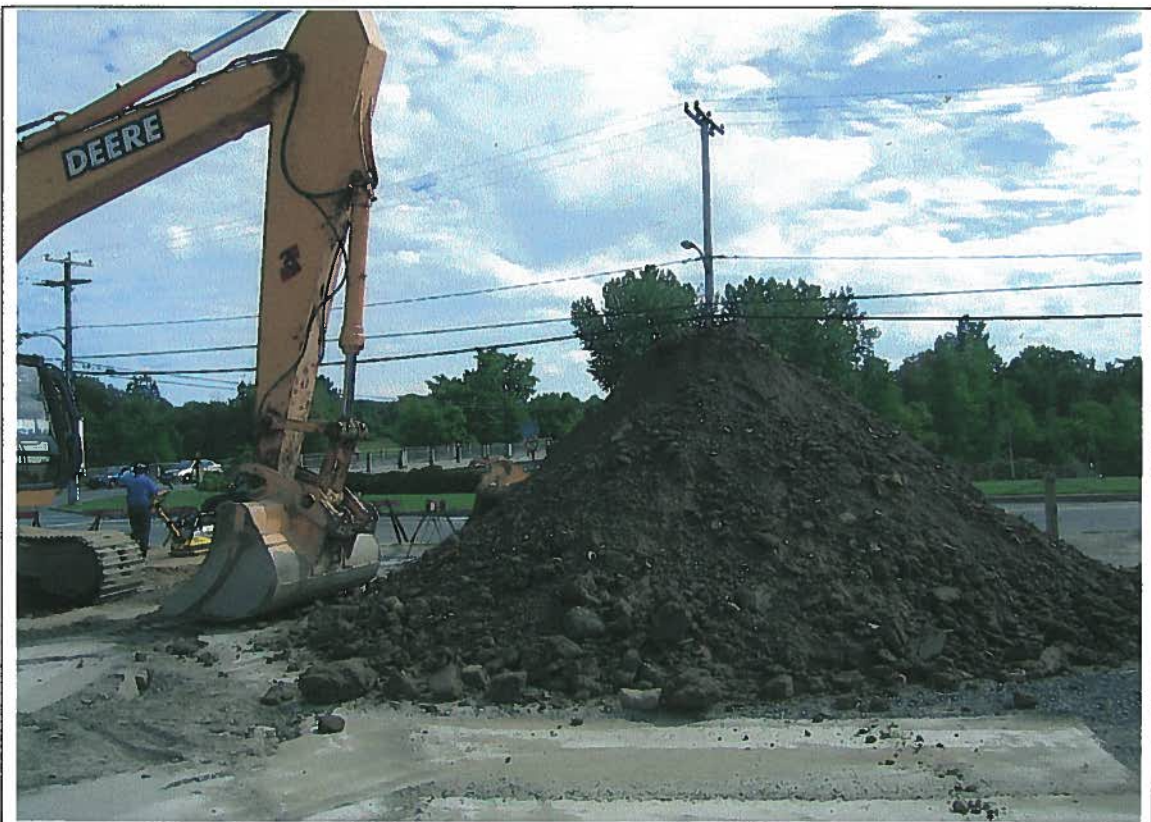
Photo 23 : Vue des sols contaminés retirés de la zone S/S-PS-2B2 en bordure de la rue Cowie le 3 septembre 2003
