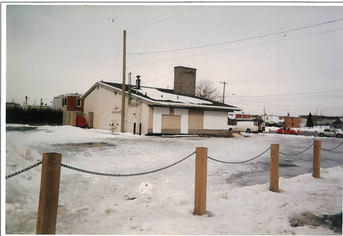
Photo 2 : Vue de la partie arrière (ouest) du site, soit le secteur réhabilité en 1998
